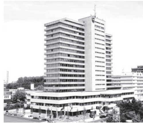
UPS Zentrale in Neuss Foto (KlausUPS)
