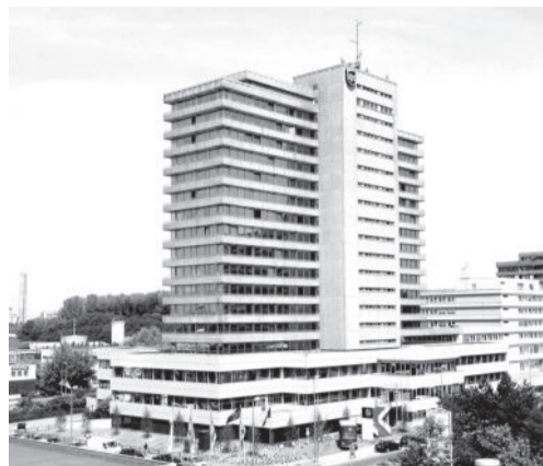
UPS Zentrale in Neuss Foto (KlausUPS)
